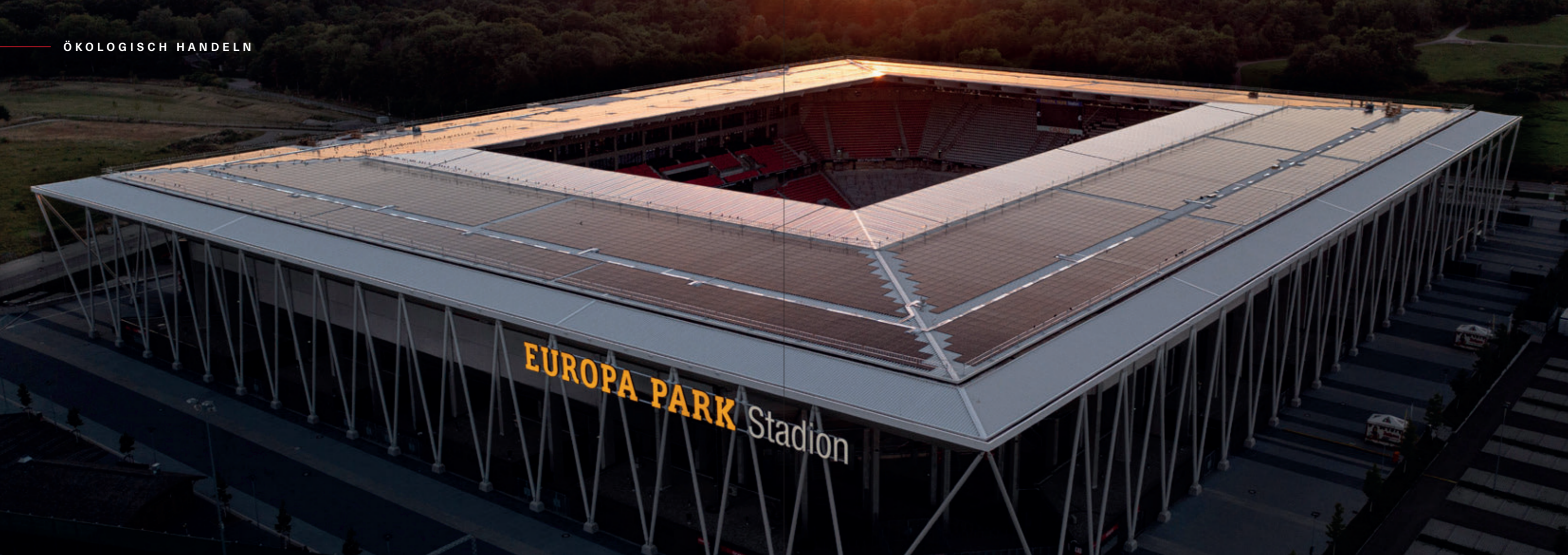
Solardach auf dem Europa-Park Stadion: Bis zu 2,6 Mio. kWh Strom pro Jahr
